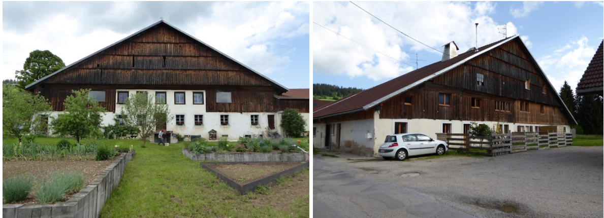
Figure 66 : (à gauche) la symétrie et l'ordonnancement d'un pignon peu transformé ; (à droite) les modifications sur une ferme divisée (proportions et emplacements des ouvertures, disparition du demi-berceau, couleurs des enduits)
